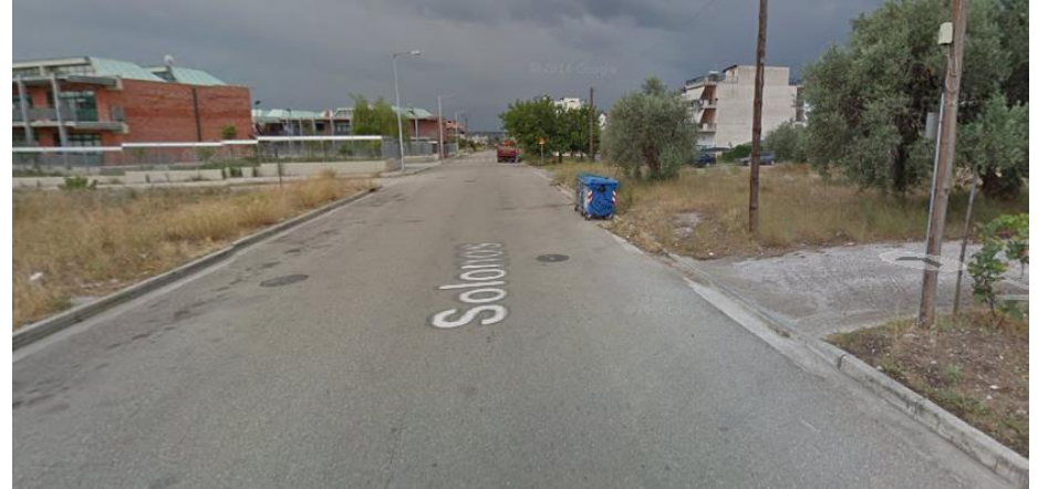
Οδός Σόλωνος – συλλεκτήρια οδός με έλλειψη του απαιτούμενου πλάτους πεζοδρομίου
