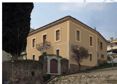
Διατηρητέο Κτίριο Πλατή
